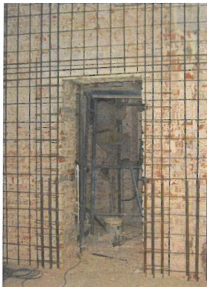
Figura 7 – Exemplu cămașă de beton la pereții de zidărie
