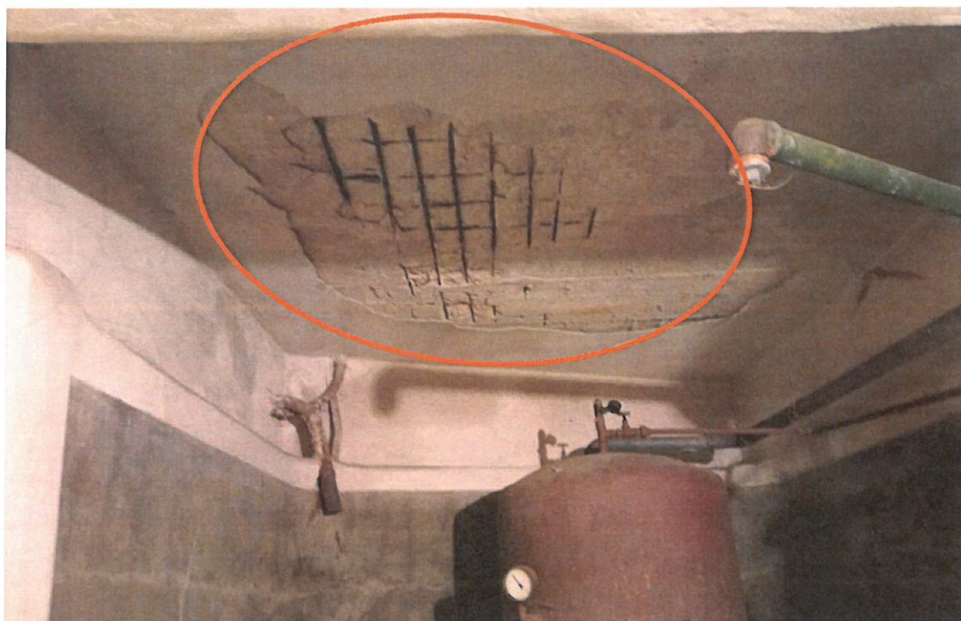
Figura 14 – Bare de armătură corodate – planșeu subsol
