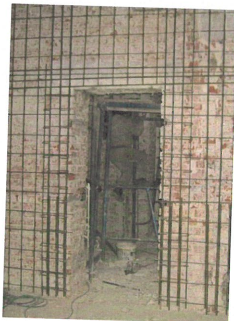
Figura 24 – Exemplu cămășă de beton la pereții de zidărie
