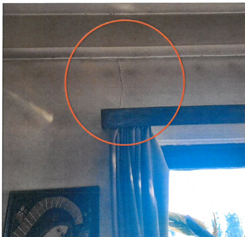
Figura 15 – Fisură într-un buiandrug fereastră, apartament 5
