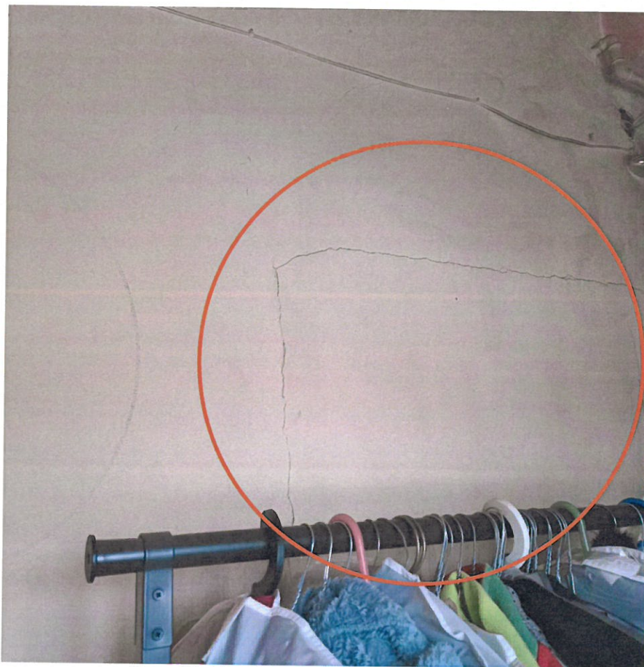
Figura 16 – Fisură în peretele de zidărie, apartament 5
