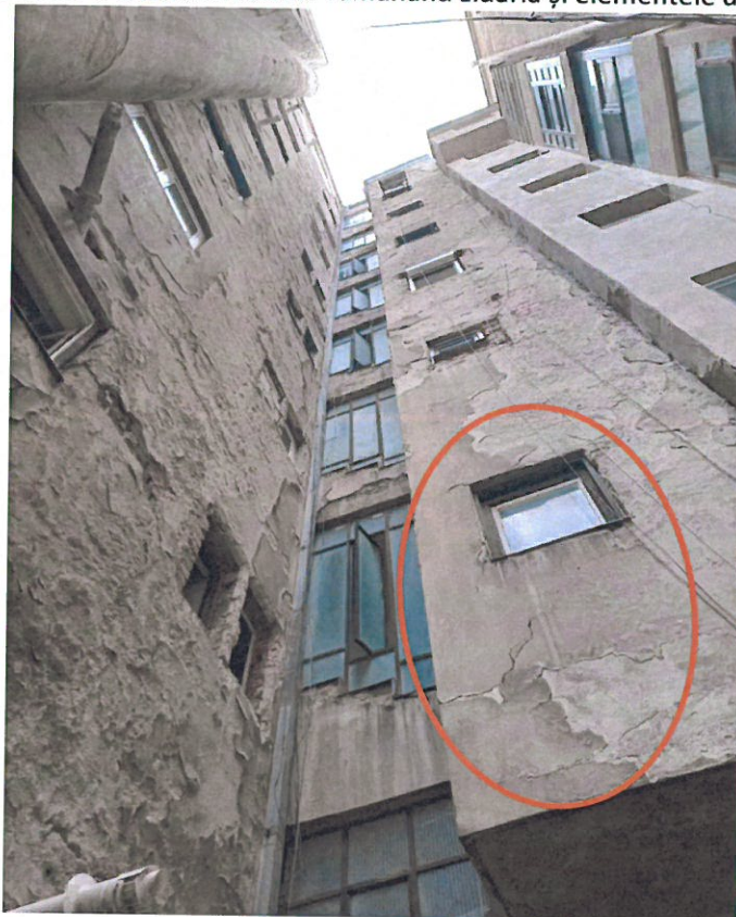
Figura 12 – Fisură fațada de vest
