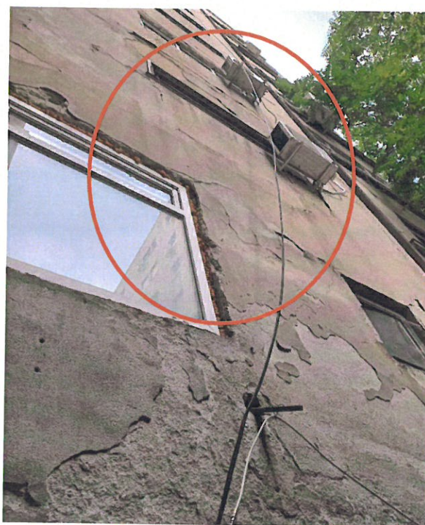
Figura 13 – Fisură fațada de est
